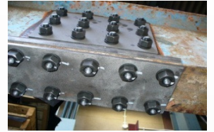
当て板補修の例
