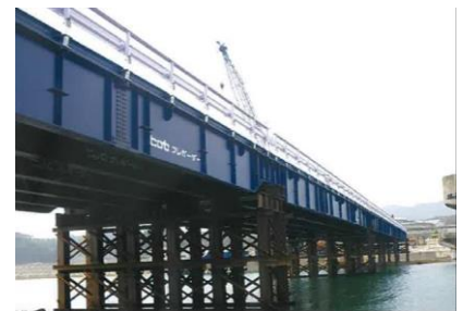
工所用仮栈橋 2)
