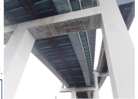
Uリブ鋼床版を用いた高架橋
