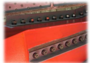
ボルト接合を用いた補剛事例 1)
