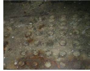
ボルト頭部の腐食事例
