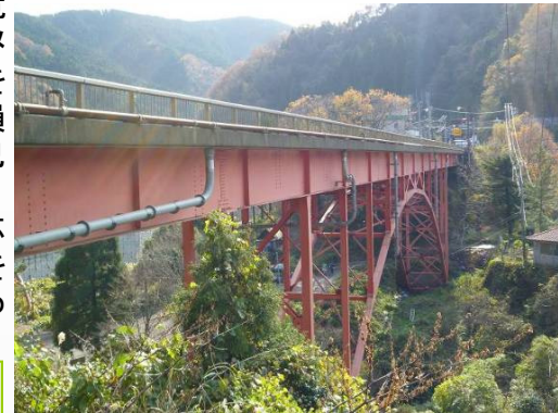
3径間上路式アーチ橋
