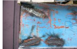
疲労亀裂の例
