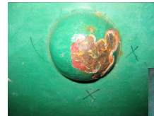
図-3 健全なリベット
