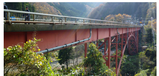
桜橋(鋼アーチ橋)
