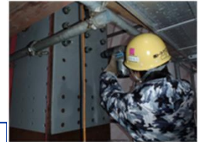
図1 片面からの当て板施工
