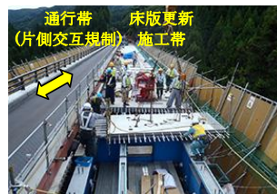
図-1 半幅員による床版取替
