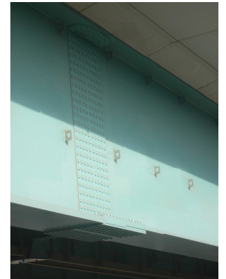
図-1 合成桁の接合部
