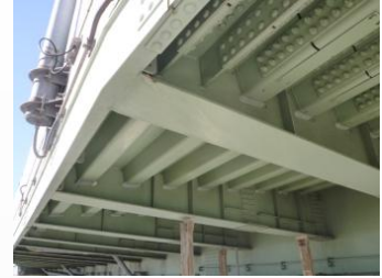
Uリブ鋼床版を有する高架橋の例
