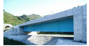
鋼ポータルラーメン橋
