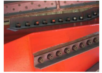
ボルト接合を用いた補剛事例 1)
