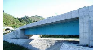
鋼ポータルラーメン橋
